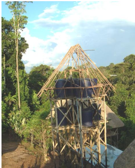
Foto 53: Reservatório de Água Fonte: Azevedo, 2004
